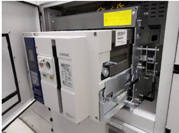
الشكل G.2 قاطع دائرة نموذجي رباعي الأقطاب قابل للسحب بالكامل
