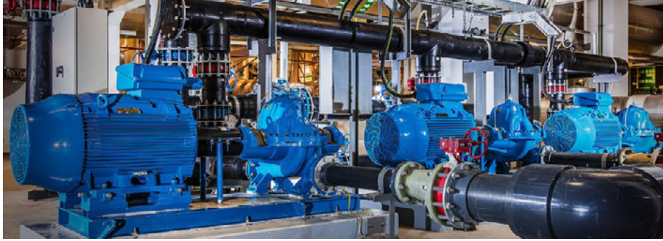
الشكل G.57 أمثلة على مضخات محطة نقل الطاقة (ETS)/محطة تبريد المناطق
