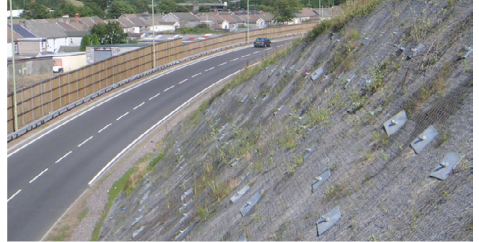
الشكل K.62 تركيب نظام تسمير التربة
