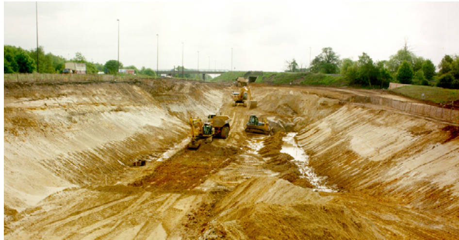
الشكل K.60 - حفريات بالقطع المفتوح
