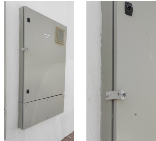
الشكل G.9 قفل حلقي نموذجي لخزانة العداد وعلامات السلك
