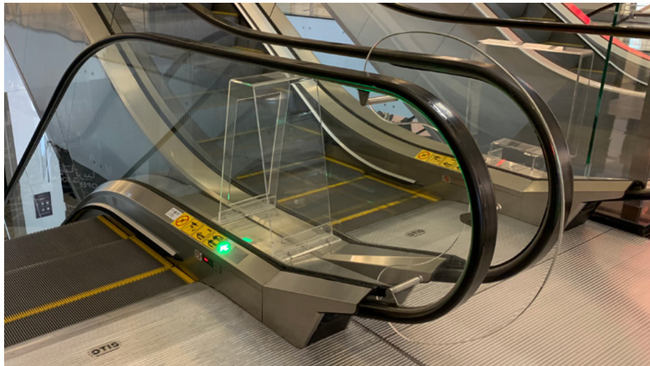
الشكل D.1 سلم كهربائي مع حماية معززة للدرازين (handrails)
