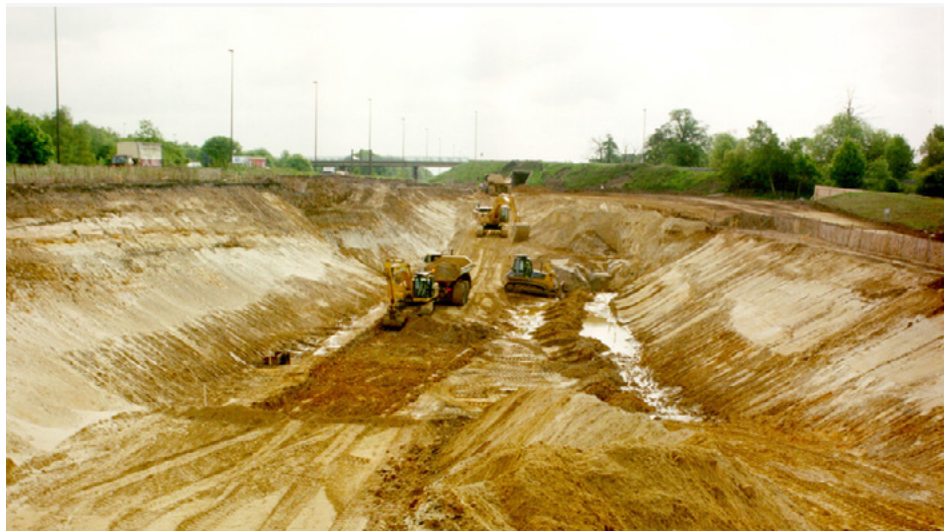
الشكل F.22 حفريات بالقطع المفتوح
