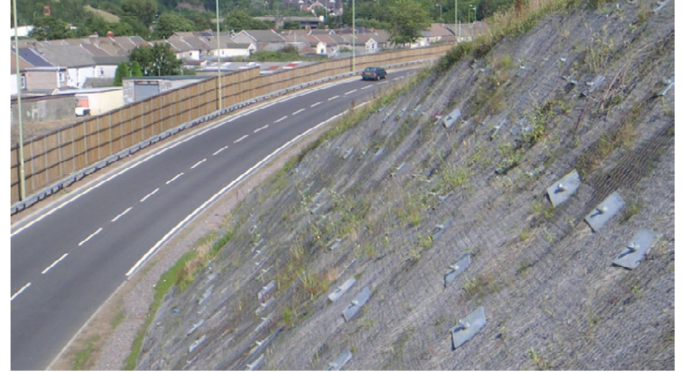
الشكل F.24 تركيب نظام تسمير التربة
